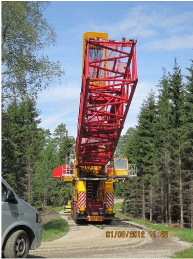
Lyftkran för vindkraftsdelar.
